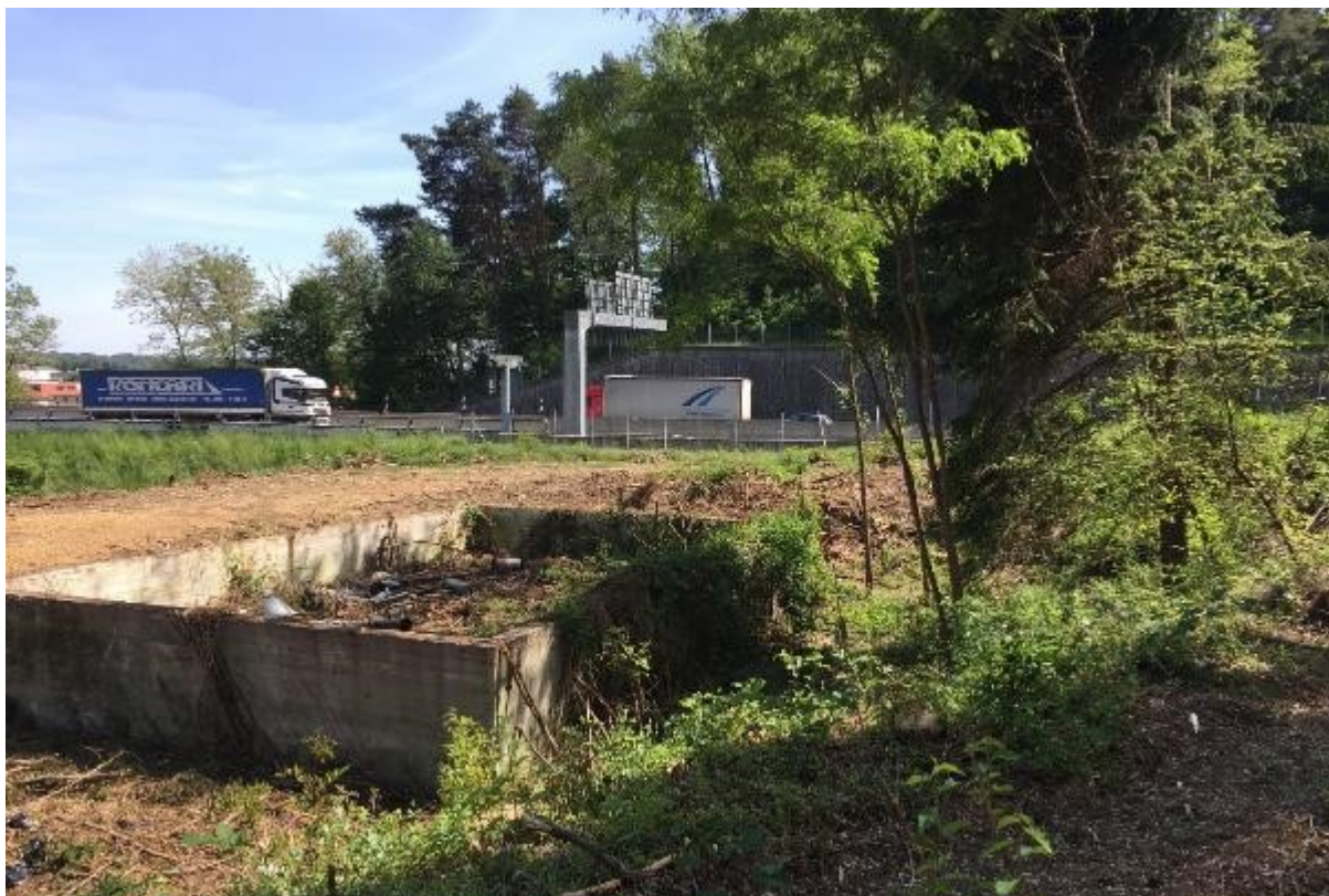
Figura 30 - Vecchia vasca antincendio. Rinnovazione.
