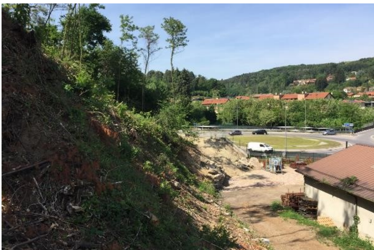
Figura 33 - Vista da Sud. Scarpata.
