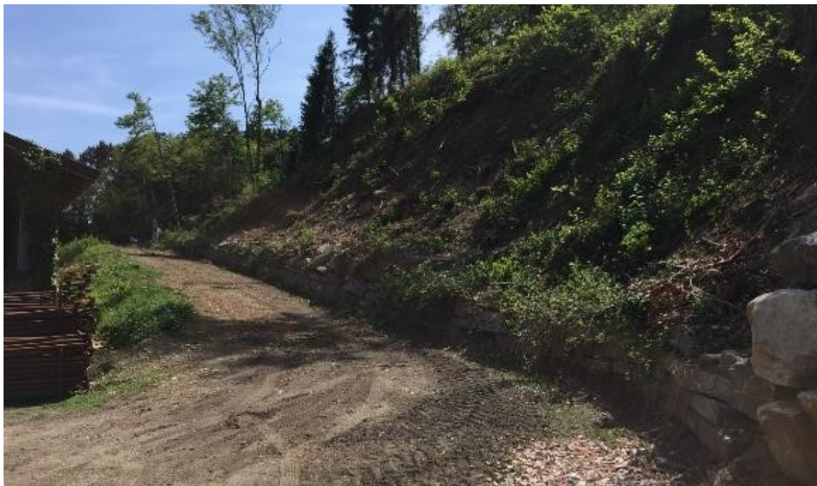
Figura 28 - In basso a dx opere di consolidamento. Strada forestale.
